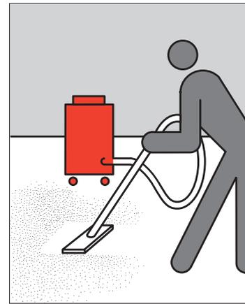
Bild 10: Staub entfernen durch Saugen.
