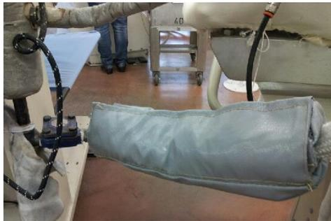
Auch eine nachträgliche Isolierung von flexiblen Anschlüssen mittels Isoliermanschette, welche mit Klettverschluss befestigt werden kann, lohnt sich.
