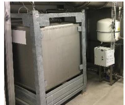
Die Wärme aus der Rückgewinnung wird zur Erwärmung des Warmwassers der Waschmaschinen verwendet. Das Warmwasser aus der Wärmerückgewinnung kann dann jeweils vor Ort bei den Waschmaschinen auf die jeweilige Temperatur des Waschprogramms eingestellt werden.
