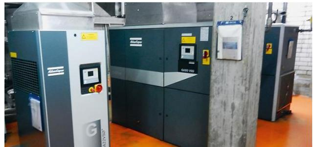
Durch die Steuerung wird jeweils die beste Kombination und Auslastung der Kompressoren ausgewählt, um die benötigte Druckluftleistung auf die möglichst effizienteste Art zu erzeugen und das Druckband mit möglichst geringen Schwankungen zu halten. Durch diese Methode wird die Druckluft möglichst präzise nach Bedarf erzeugt und somit Energie eingespart. Laut Herstellerangaben ist mit Energieeinsparungen von rund 10 Prozent zu rechnen.
