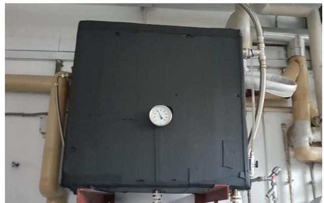
*Isoliertes Speisewassergefäss, das durch die Isolation die Wassertemperatur hoch hält.*
