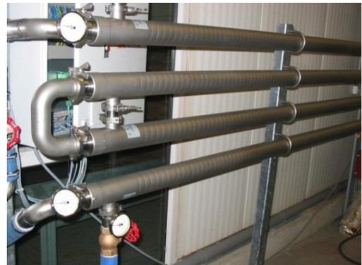
*Abwasserwärmetauscher Jensen Spiralizer, interne Verrohrung und Steuerung in der Waschstrasse. Links: Auf dem Dach der Waschstrasse montiert. Rechts: An der Wand neben der Waschstrasse montiert.*
