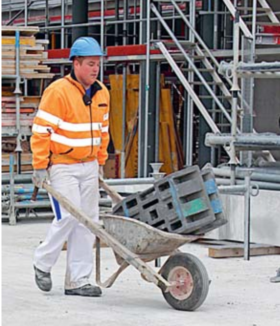
Konsequent Transporthilfsmittel einsetzen.
