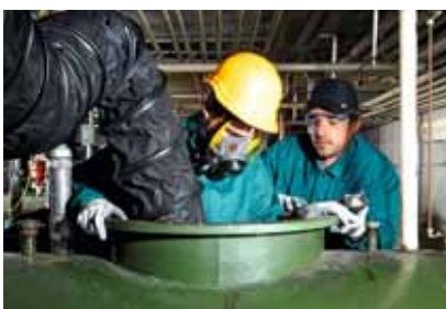
1 Schleifarbeiten in gereinigtem Tank: Ventilation und Atemschutz erforderlich
