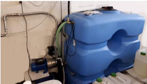
Ein 800 Liter Kunststofftank und eine Pumpe mit ca. 3.5 Bar Druck reichen aus, in einem Ladenbetrieb den Warmwasserbedarf der Waschmaschine 20 Kg voll zu decken. Dazu die Einsparung von Heizenergie, da die meiste Wäsche in der Textilreinigung entweder Hemden bis 50°C sind oder Feinwäsche ist. Das Kühlwasser wird oben eingeleitet, am Boden ist eine Entnahme für die Pumpe, dazu wurde ein
