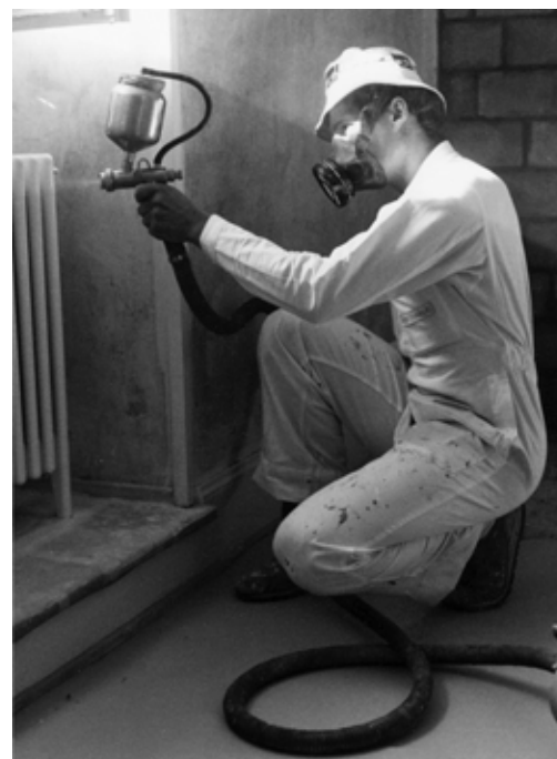
Fig. 6: si l'aération est insuffisante, il faut porter un appareil adéquat de protection respiratoire.
