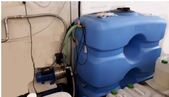
Un réservoir en plastique de 800 litres et une pompe d'une pression d'environ 3,5 bars suffisent à couvrir entièrement les besoins en eau d'une machine à laver de 20 kg dans un magasin. S'y ajoute une économie d'énergie de chauffage, puisque la plupart pièces traitées en pressing sont soit des chemises lavables jusqu'à 50°C, soit du linge délicat. L'eau de refroidissement est introduite par le haut, en
