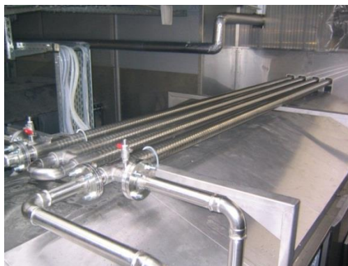
Echangeur thermique pour eaux usées Jensen Spiralizer, tuyauterie interne et commande dans le tunnel de lavage. A gauche: installation sur le toit du tunnel de lavage. A droite : installation sur le mur à côté du tunnel de lavage.
