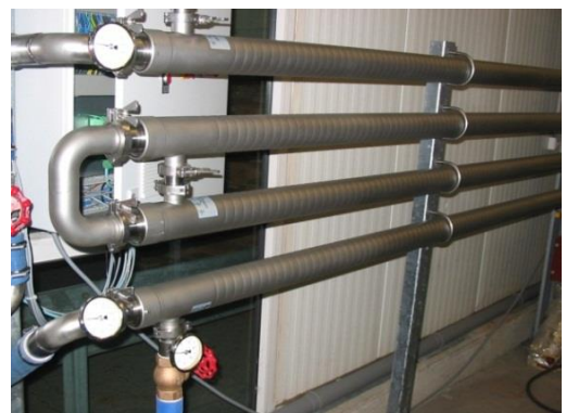
Echangeur thermique pour eaux usées Jensen Spiralizer, tuyauterie interne et commande dans le tunnel de lavage. A gauche: installation sur le toit du tunnel de lavage. A droite : installation sur le mur à côté du tunnel de lavage.
