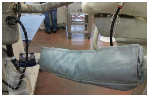
Manchon d'isolation flexible. (Photo: WöschChorb Wallisellen)
