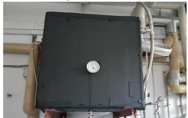
Récipient d'eau d'alimentation isolé permettant de maintenir une température élevée de l'eau.
