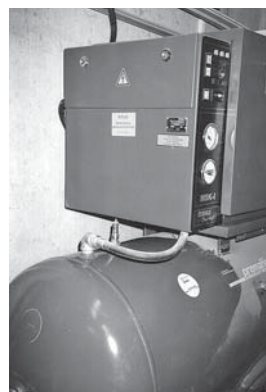
Fig. 2: les équipements sont facilement accessibles.
