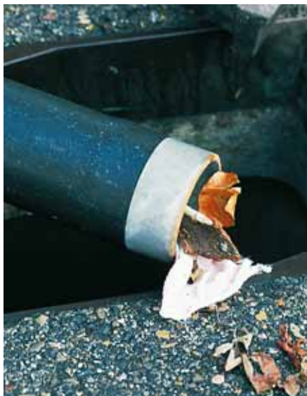
Figure 13 Si lors de travaux d'entretien de canalisations on tombe sur une seringue...
