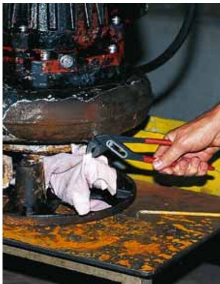
Figure 12 Les objets obstruant les canalisations d'eaux usées ne doivent être saisis qu'au moyen d'instruments.
