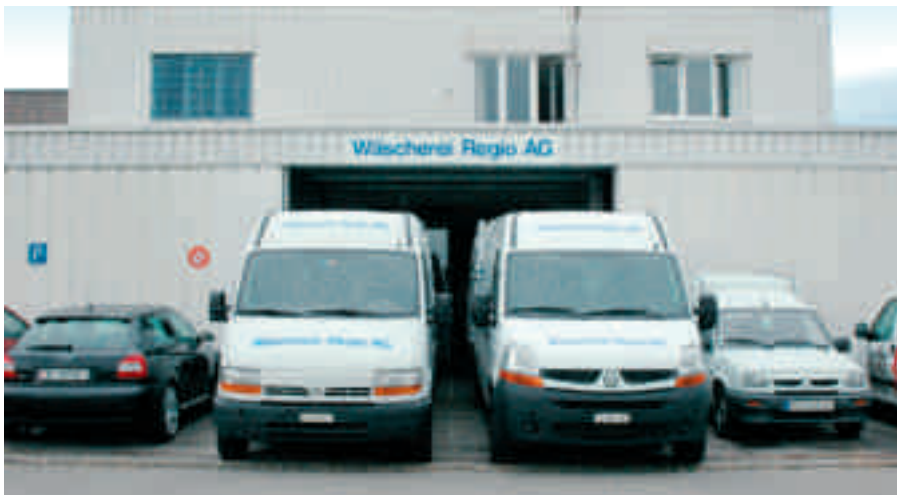
Die Wäscherei Regio AG in Aesch BL setzt auf Energieeffizienz und Umweltschutz.
